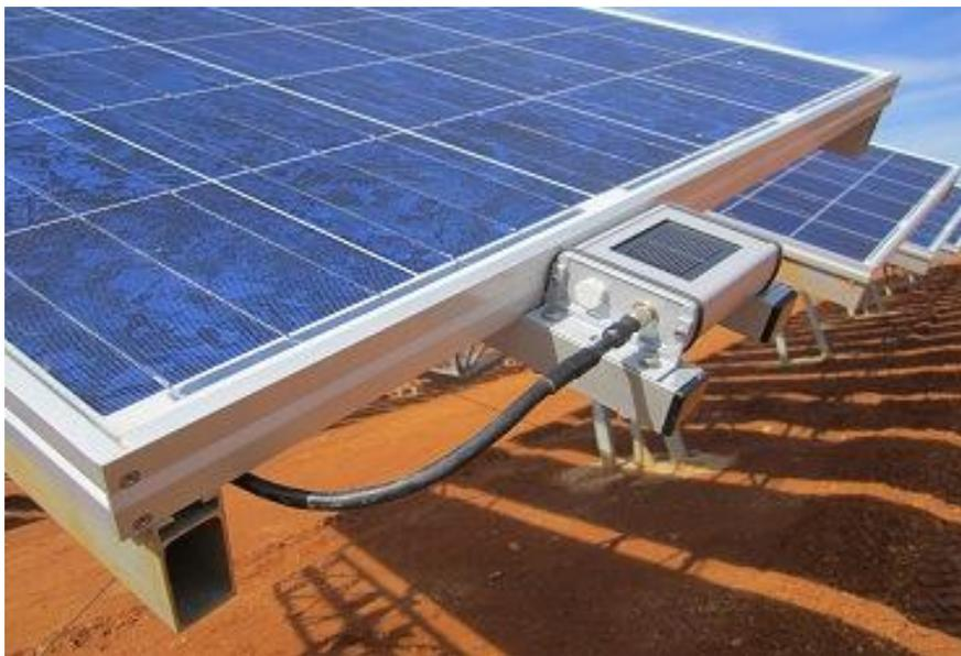
Figura 38. Ejemplo de celda de referencia.
